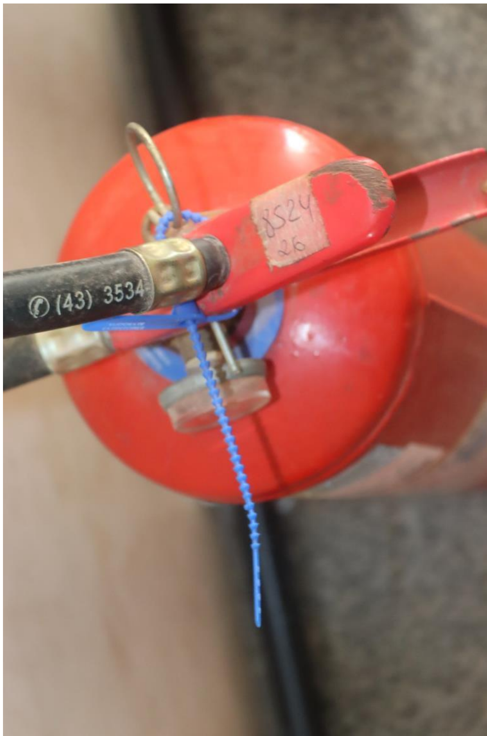
Fotografia 67 – Lacre de um dos extintores de incêndio.
